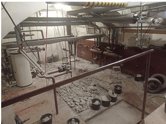
Téměř vyprázdněný prostor kotelny byl připraven k montování nových kotlů
