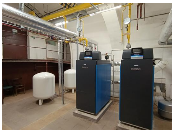
Nová plynová kotelna zhotovená firmou Kernbach, s.r.o. za 3,9 mil Kč a byla předána k užívání dne 26.10.2024
