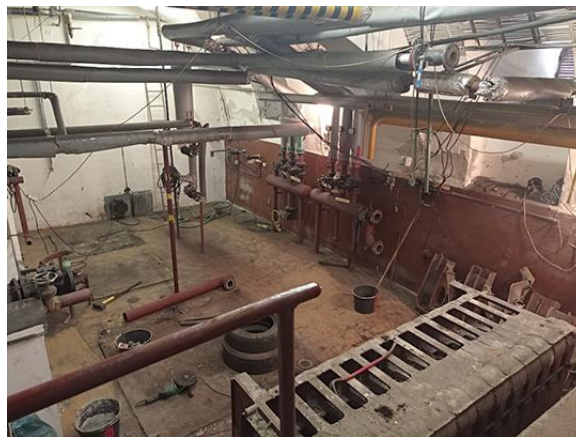
V srpnu byla zahájena demontáž a postupně se z ní vynášely těžké kusy starého kotle
