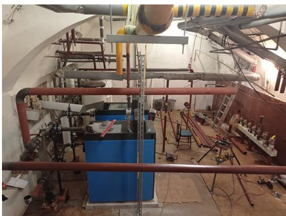
Postupná montáž kotlů a příslušenství se chýlila ke zdárnému konci díky projektové dokumentaci společnosti ATRIS s.r.o.
