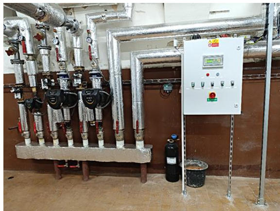
Fotografie zobrazuje dokončenou instalaci rozvodů topení v naší nové plynové kotelně
