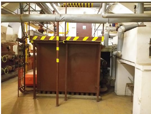
Stará plynová kotelna z 50let minulého století na jaře 2024 navždy dosloužila
